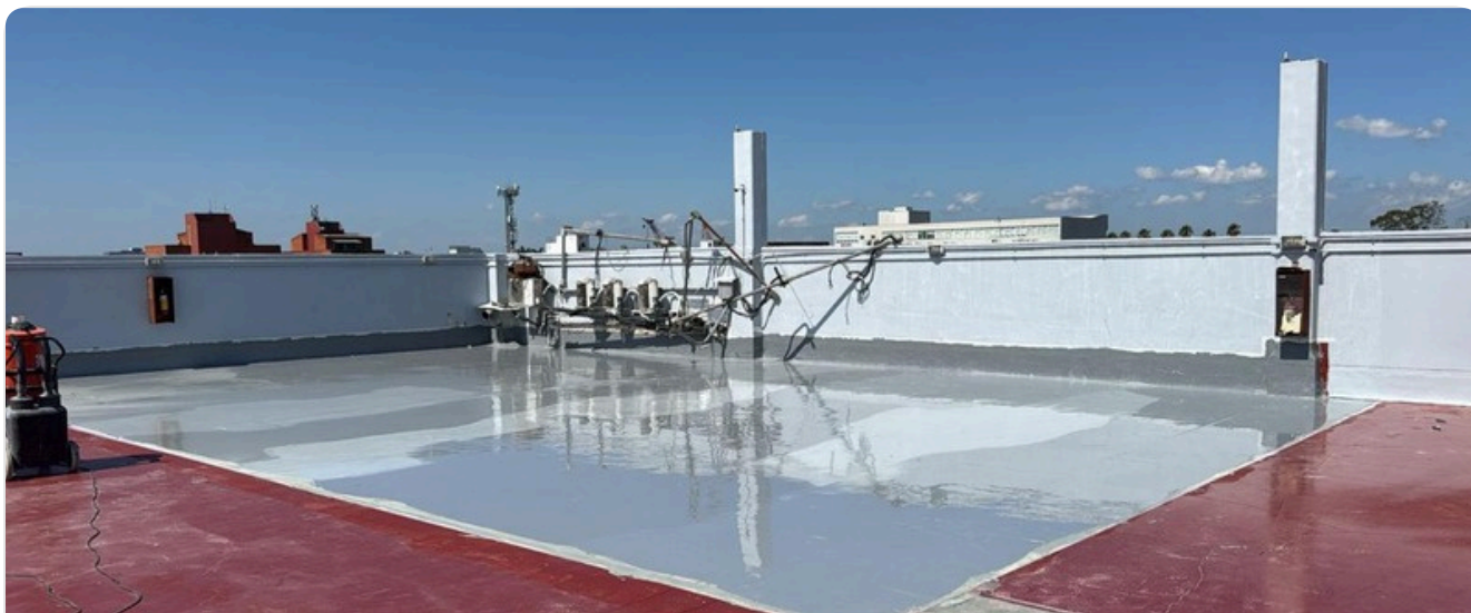
Aplicação em cobertura técnica - membrana contínua e refletiva
